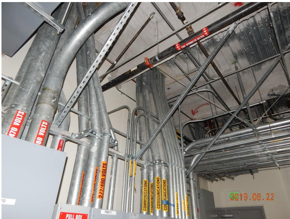
Photo 6. Conduit Bracing
